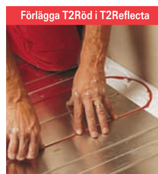
T2Röd förläggs i de färdiga spårerna i T2Reflecta-skivorna. Värmeavgivningen avgörs av hur tätt du lägger värmekabeln.
