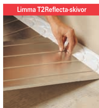
T2Reflecta-skivorna kan limmas på det bärande undergolvet...
