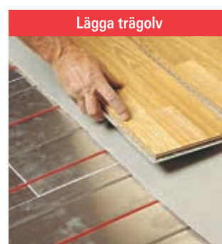
Placera lumpapper eller foam ovanpå T2Reflecta-skivorna och lägg därefter det nya trä- eller laminatgolvet enligt tillverkarens anvisningar.
