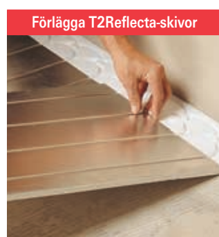
T2Reflecta-skivorna läggs löst (behöver inte limmas eller skruvas) ovanpå det bärande underlaget.
