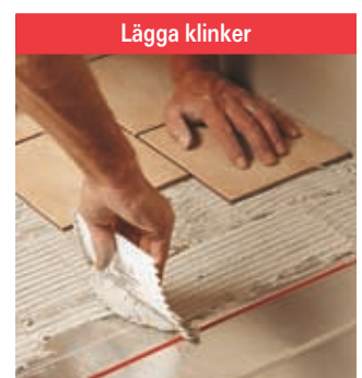
Klinkern sätts ovanpå T2Reflecta-skivorna enligt instruktionerna. Cirka 1 dygn efter fogningen kan du njuta av ditt varma, sköna golv.
