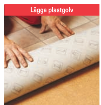
Om det nya golvet är en plastmatta läggs först en 6-8 mm renoverings- eller underlagskiva ovanpå lumpappen/foamen. Lägg sedan plastmattan enligt tillverkarens anvisningar.
